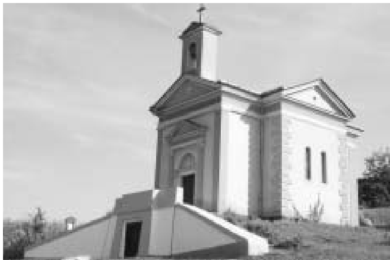
A felújított kápolna
